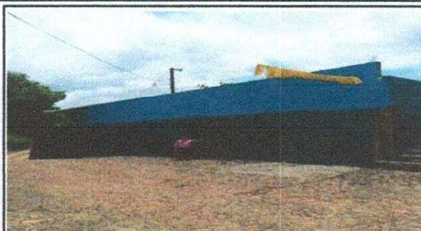
Foto 2: Pintura en el exterior del muro perimetral.
