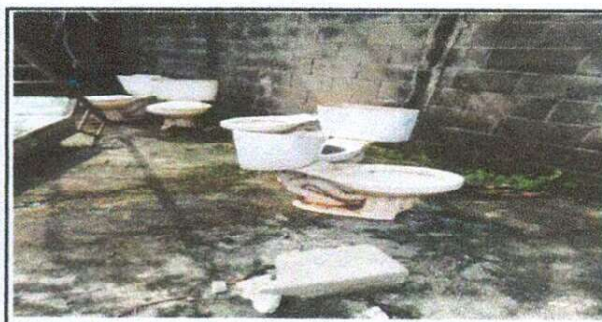
Foto 5: Desinstalación de batería de baño.
