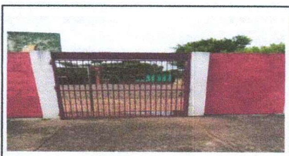
Foto 6: Mantenimiento a portón.
